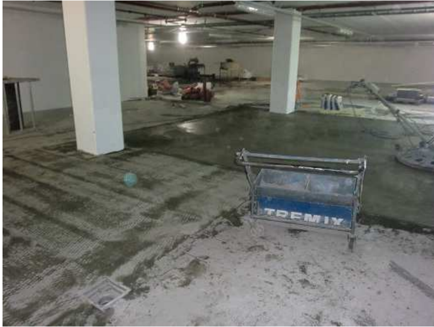
Figur 2 – Foto av garagepågjutning som visar pågående skurning/glättning av en delyta och en delyta som just har ströats med hårdbetong.
