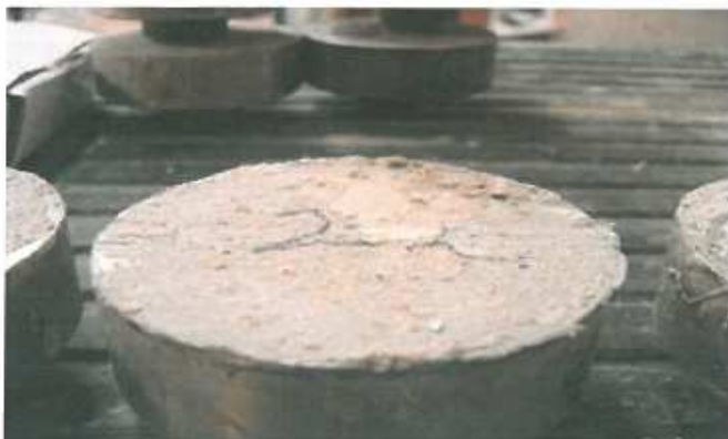
Foto 9 Dragklacka 2.2 : Svag vidhäftning mellan översta betongskikten
