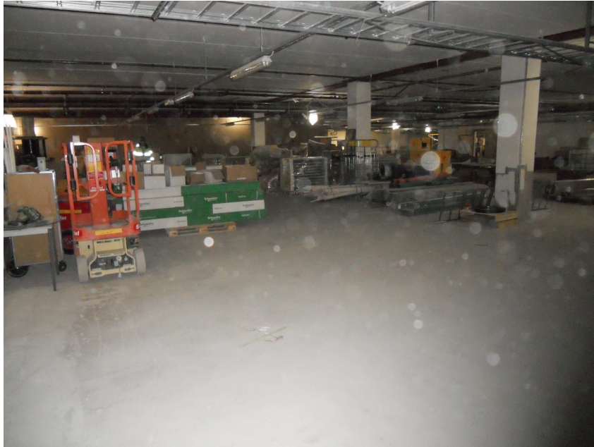
Figur 6 – Vid besiktningen var provytan belamrad med olika byggvaror, vilket gjorde det svårt att göra en noggrann kartering av hela ytan.
