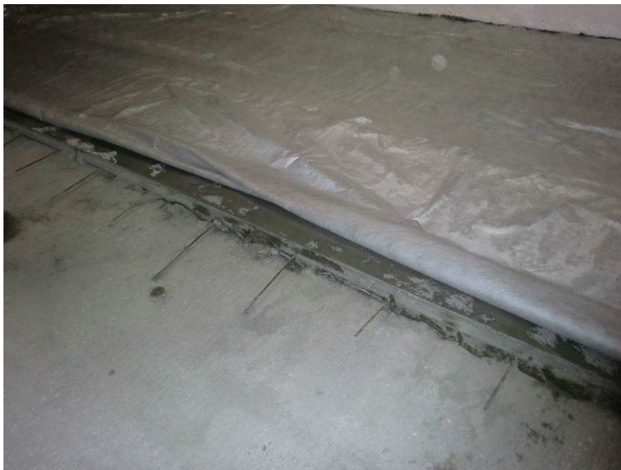
Figur 3 – Efter avslutad glättning täcktes pågjutningarna i garaget in med plastfolie under ca 1 veckas tid.
