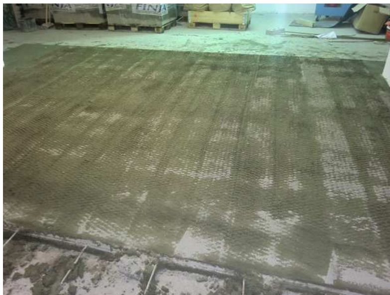
Figur 1 – Foto som visar en del av pågjutningen i garagedelen som har vakuumsugits och ströats med hårdbetongpulver.
